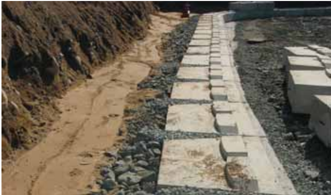
Drenering bak muren
