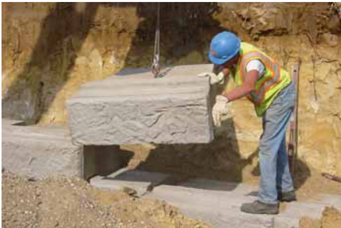
Plassering av blokk ved hjelp av løfteanker
